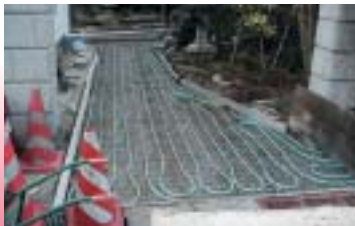
【施工例】写真融雪工事額 約70万円 約22㎡
