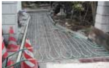
【施工例】写真融雪工事額 約70万円 約22㎡
